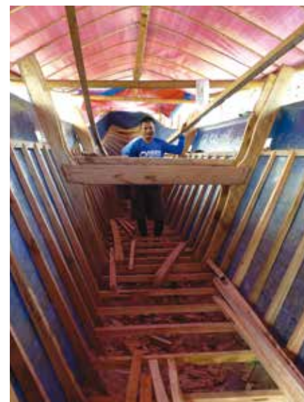
Stairways nye bangka bygges i hånden i glasfiber med træskelet på et lokalt bådebyggeri
